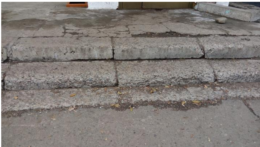
Фото 29. Входная площадка (перед дверью)
