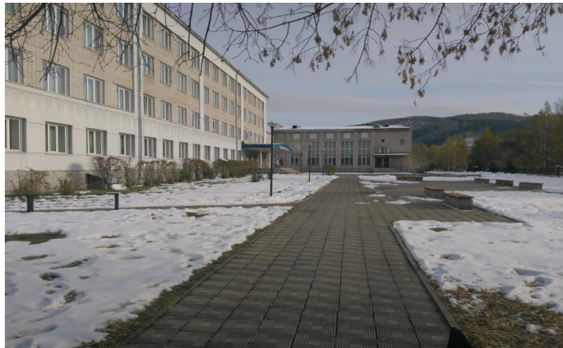
Фото 7. Путь (пути) движения на территории (освещение)
