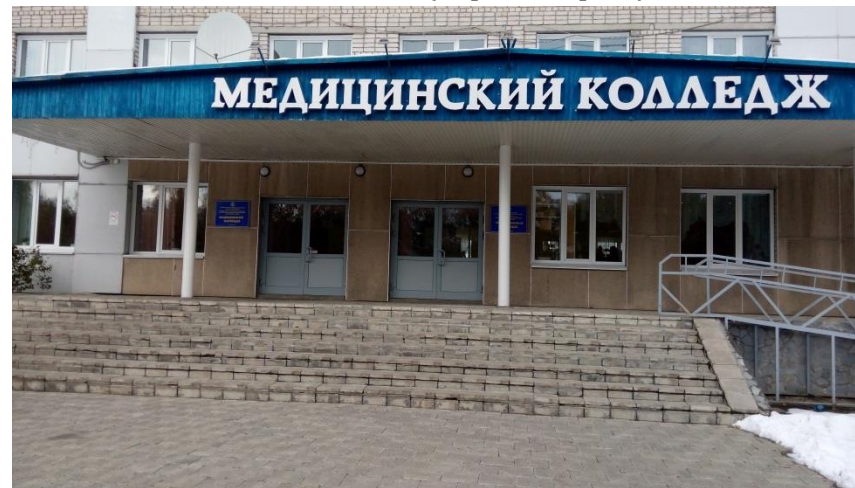
Фото 11. Входная площадка (перед дверью)
